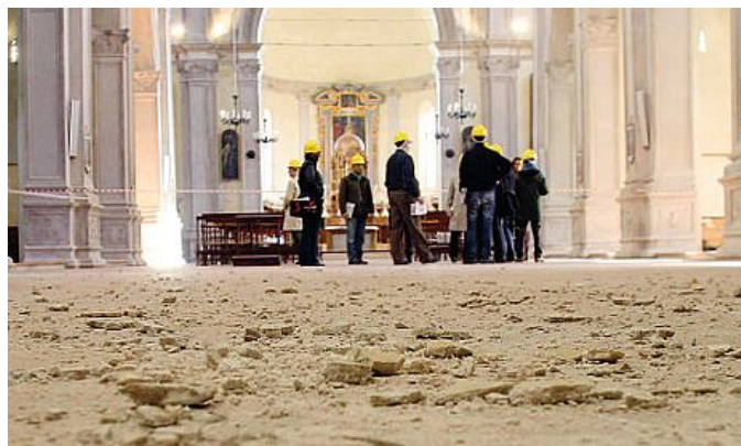
Sopralluogo all'interno della chiesa di San Cristoforo alla Certosa
