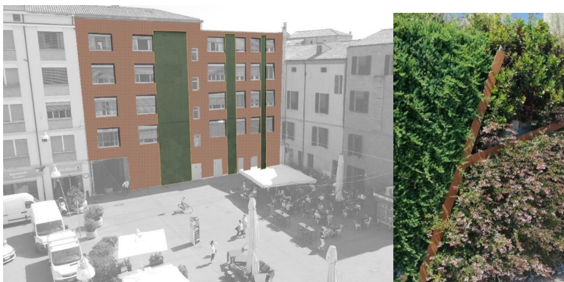
Figura 3 Il sistema di verde verticale potrebbe essere integrato in una parete ventilata realizzata in lamiera stirata che contribuirebbe alla termoregolazione naturale e a riqualificare esteticamente il prospetto del fabbricato.
