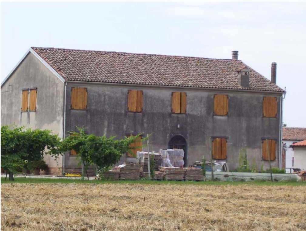
vista da nord
