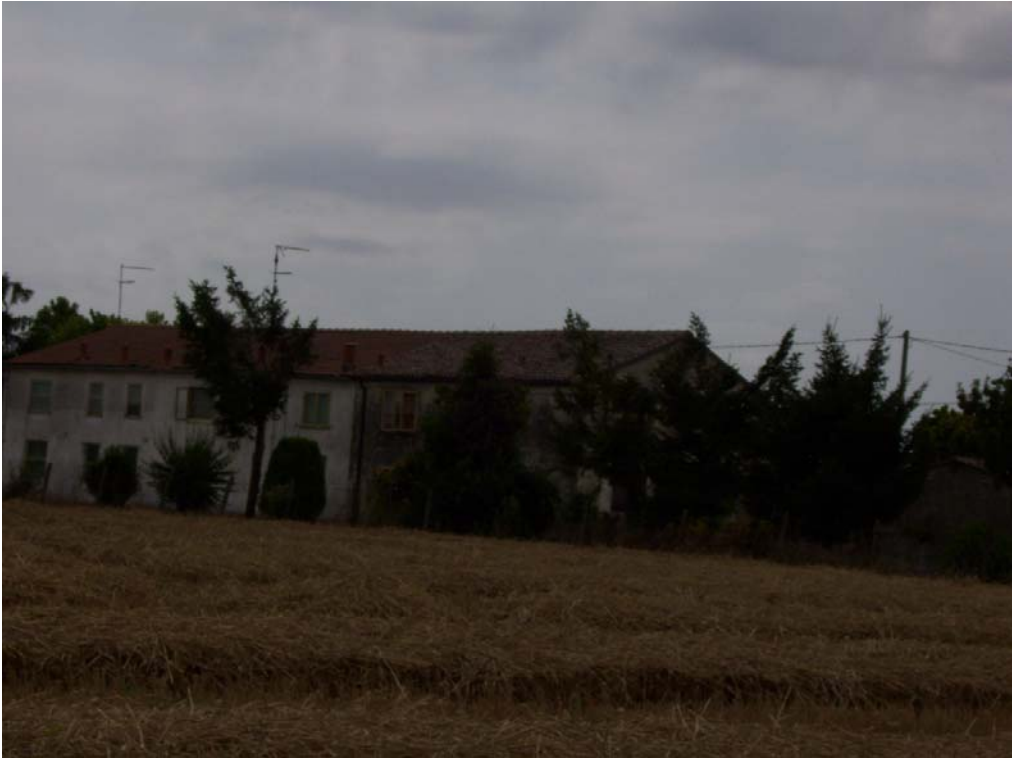
vista da nord
