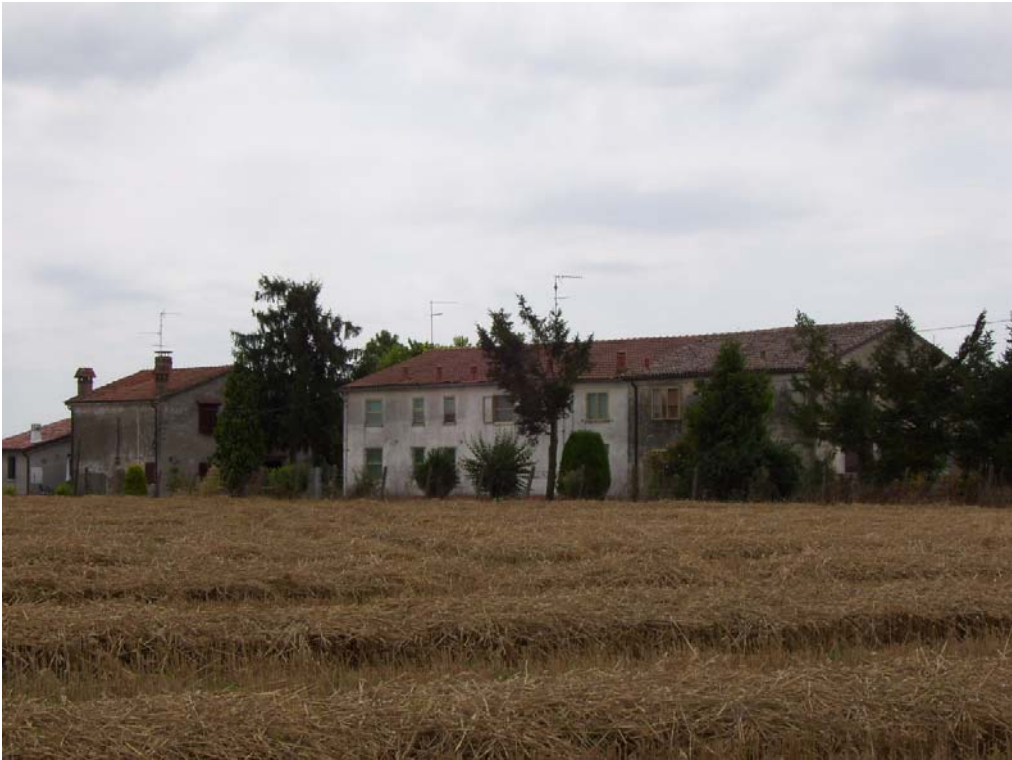
vista da nord
