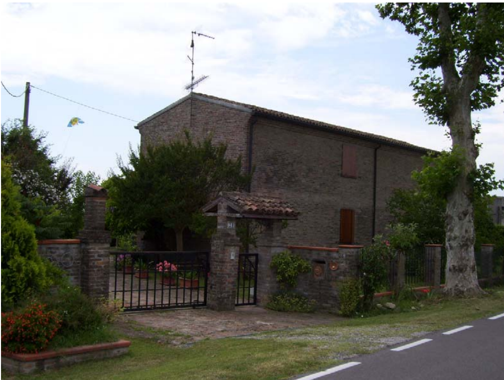
vista da nord
