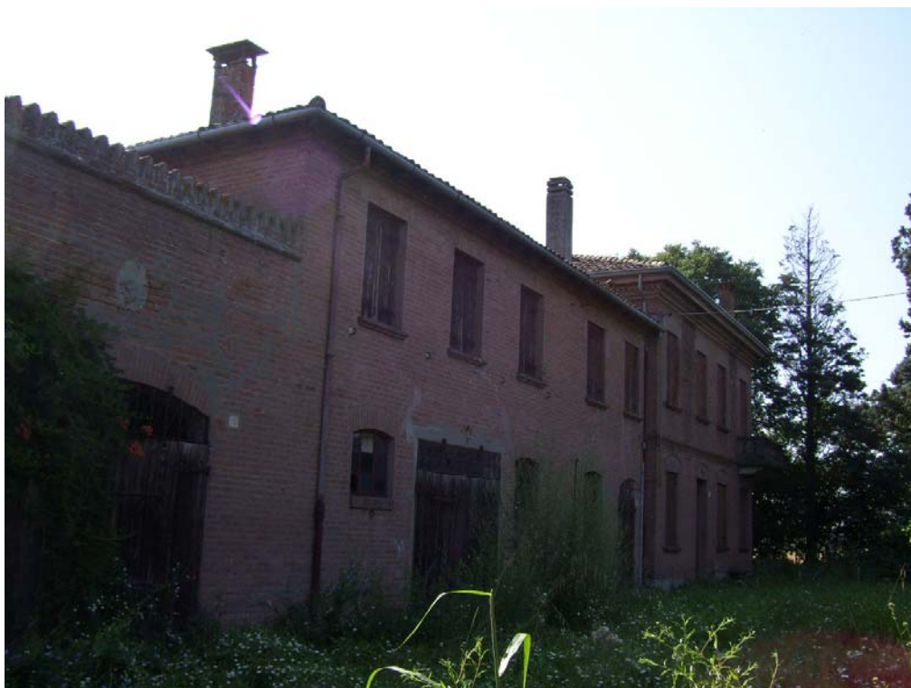
vista da ovest
