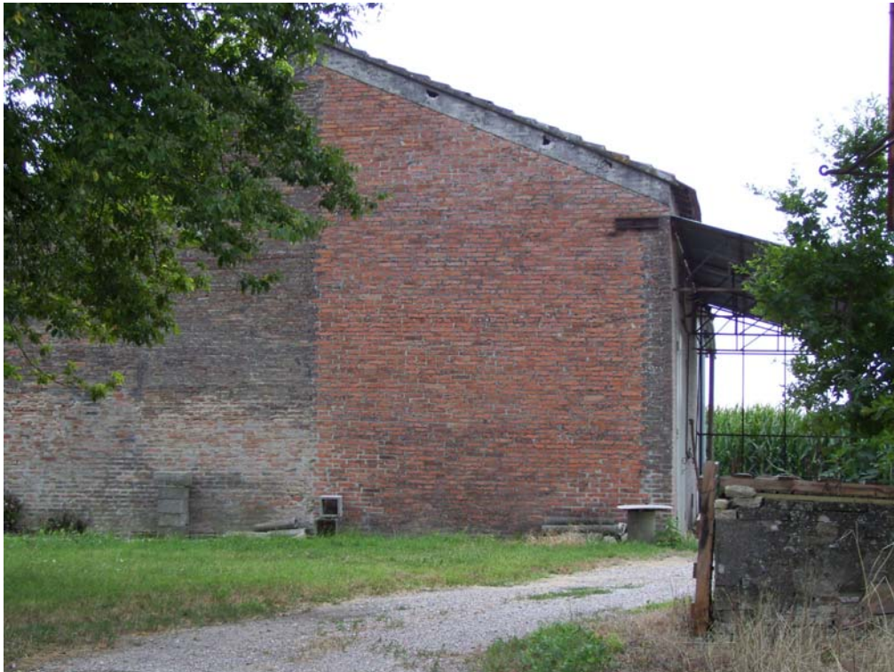
vista da nord
