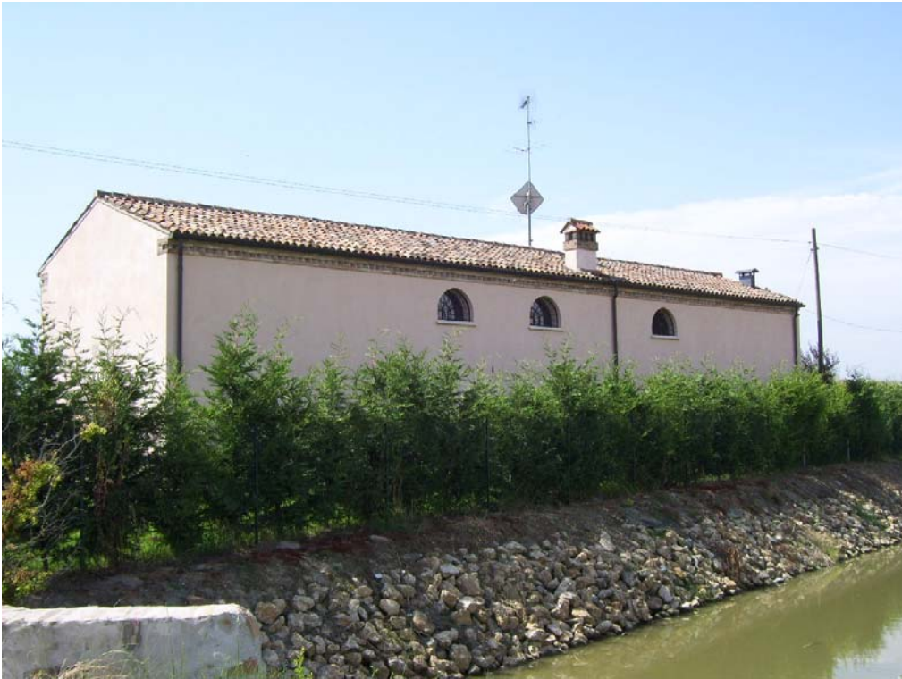
vista da nord
