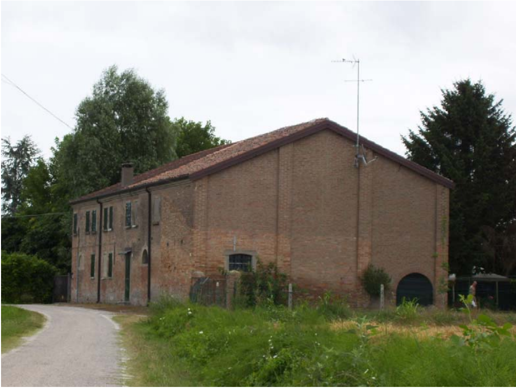
vista da ovest
