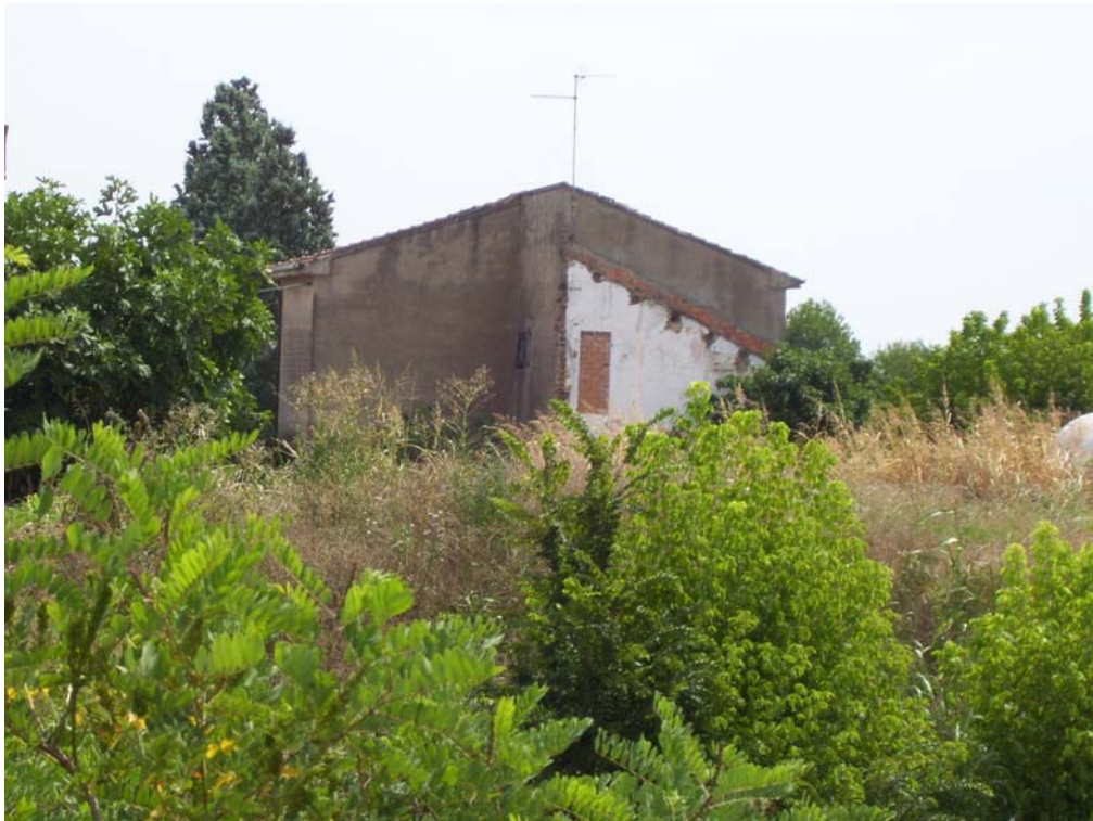
vista da ovest
