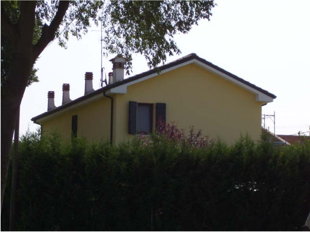
vista da ovest
