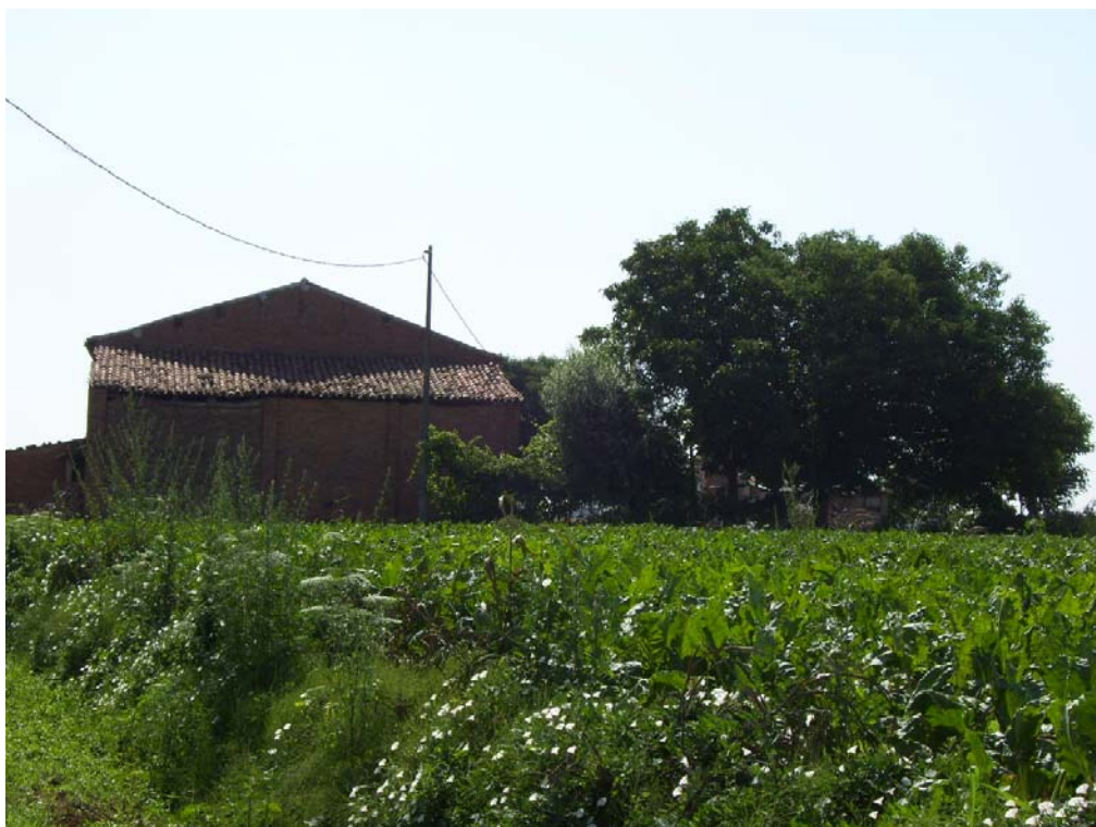
vista da ovest
