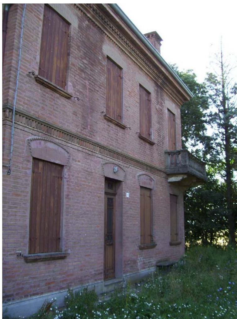
vista da ovest
