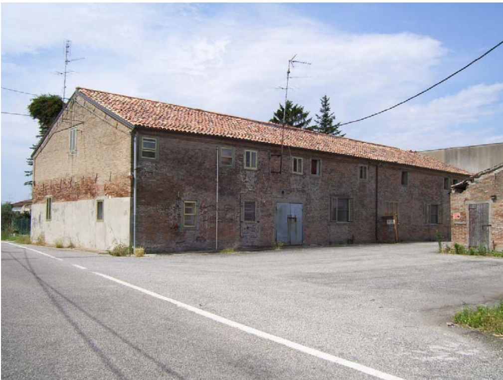
vista da nord
