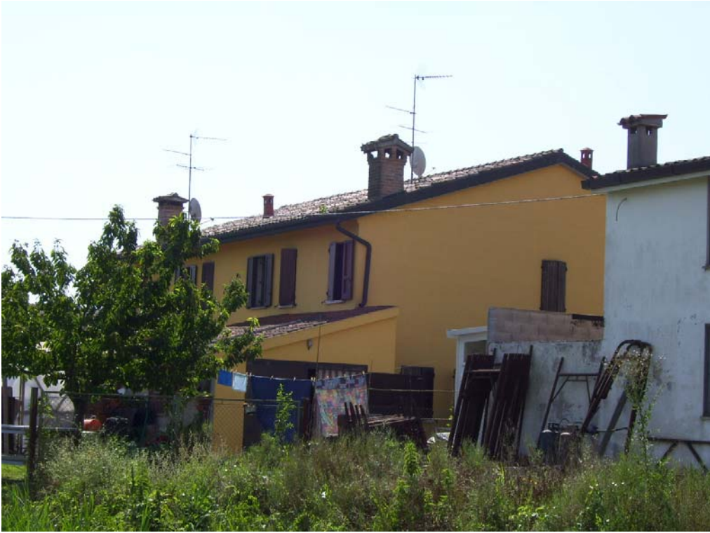
vista da nord
