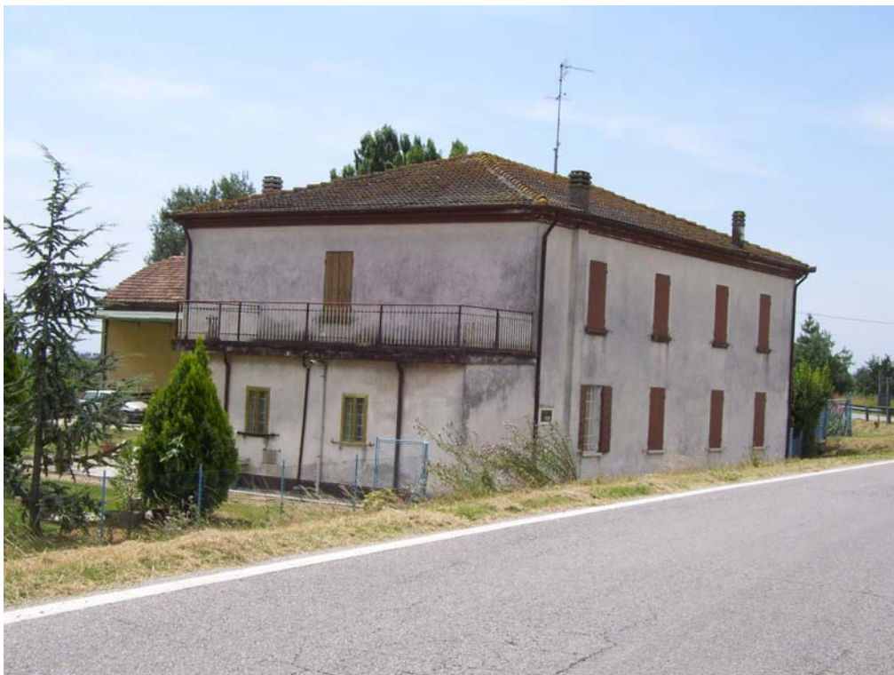
vista da nord
