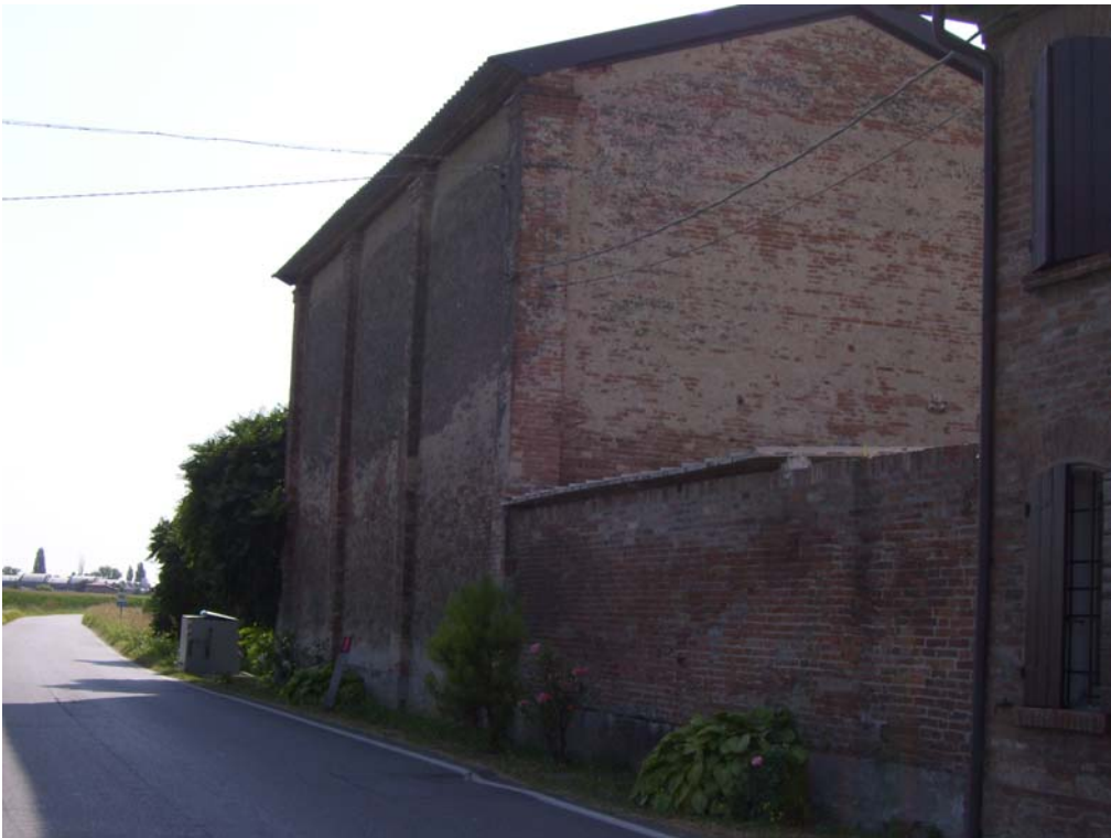
vista da ovest
