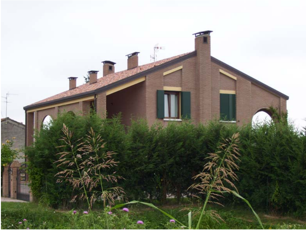
vista da nord
