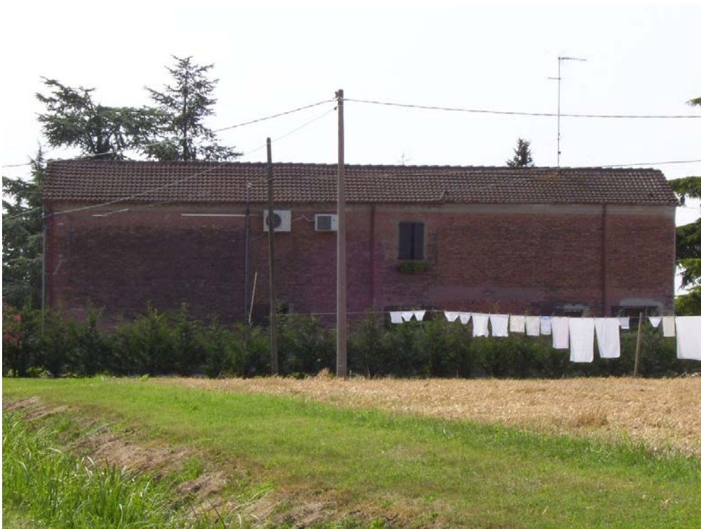
vista da nord
