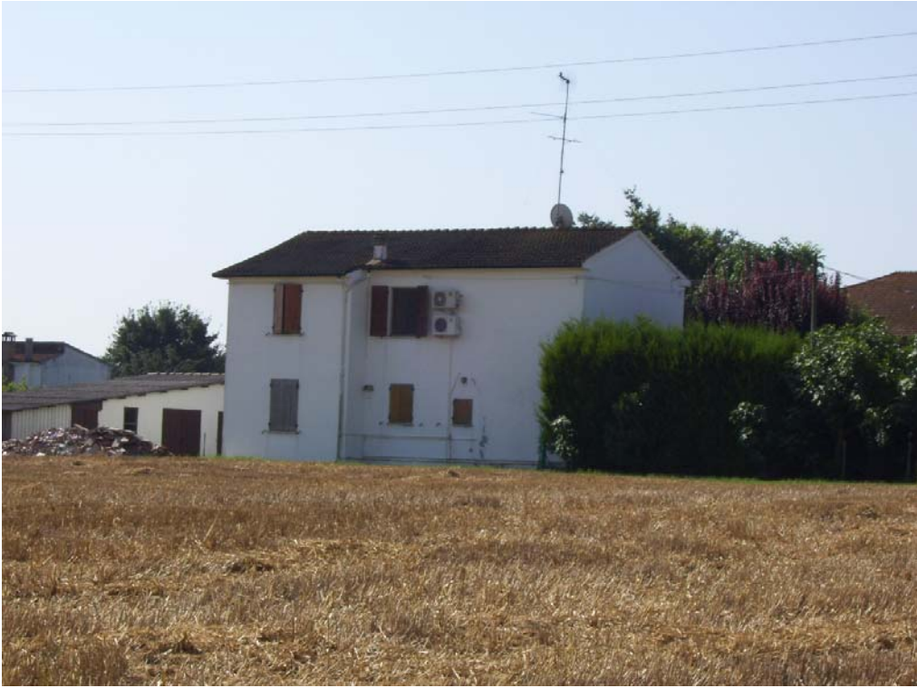
vista da nord
