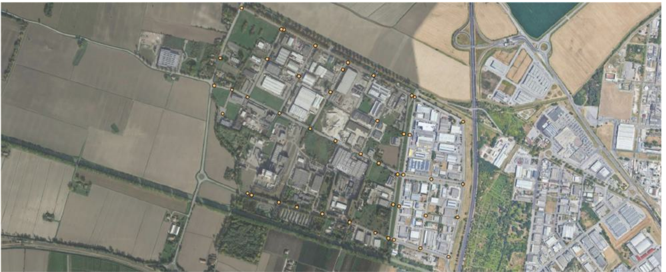
Fig. 14 – Pozzetti di linea fognari rilevati
