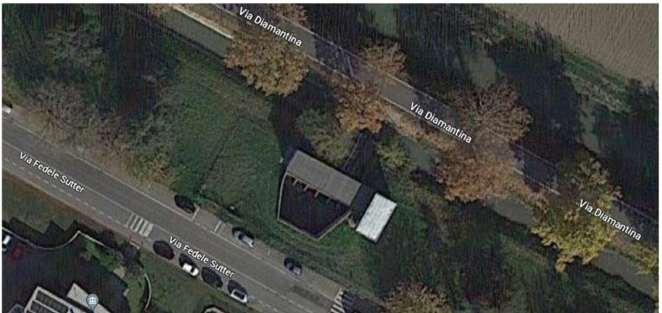
Fig. 19 – Ortofoto impianto di sollevamento di via Sutter – zona nord
