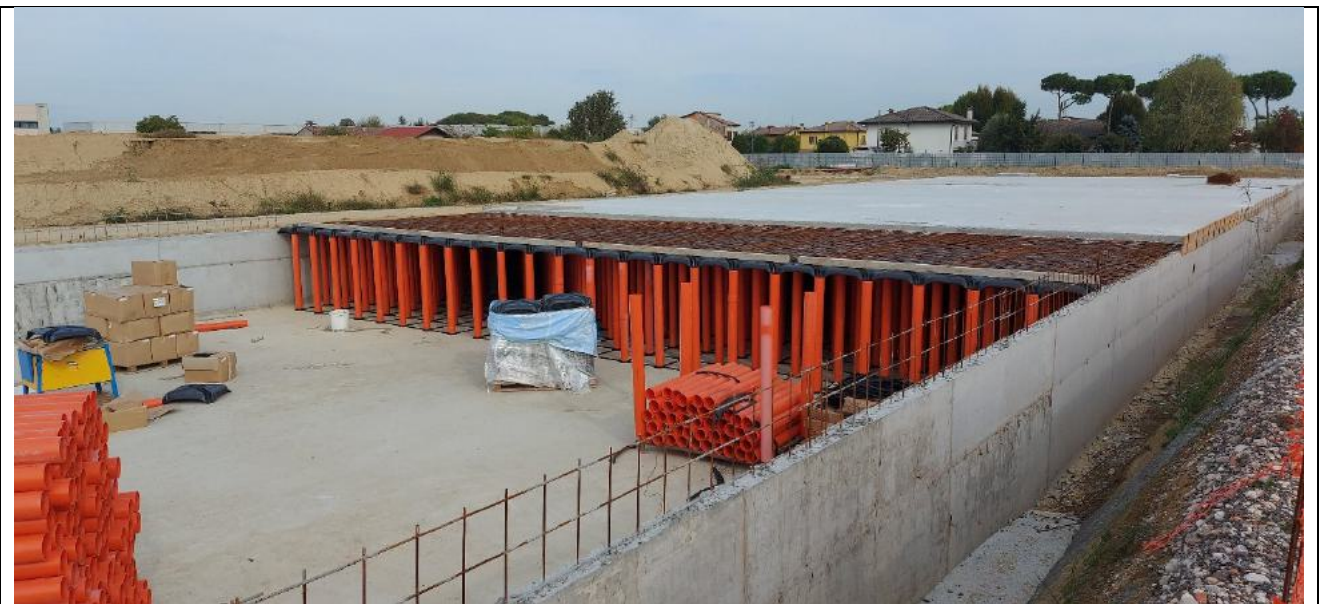
Fig. 92 – Vasca dimensioni 150 m x 27 m x H 1,4 metri – Volume utile pari a 4.800 mc (area industriale di Cadoneghe - Padova)
