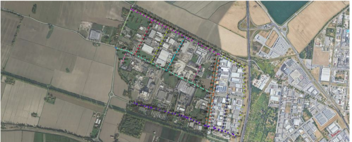
Fig. 13 – Pozzetti di linea fognari (sopra e sotto asfalto)
