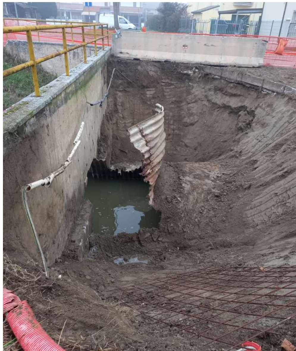
Foto dei Lavori
