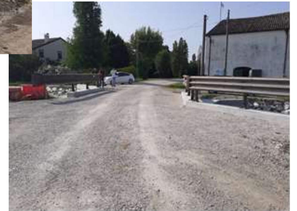
Piano viabile con nuove barriere di sicurezza
