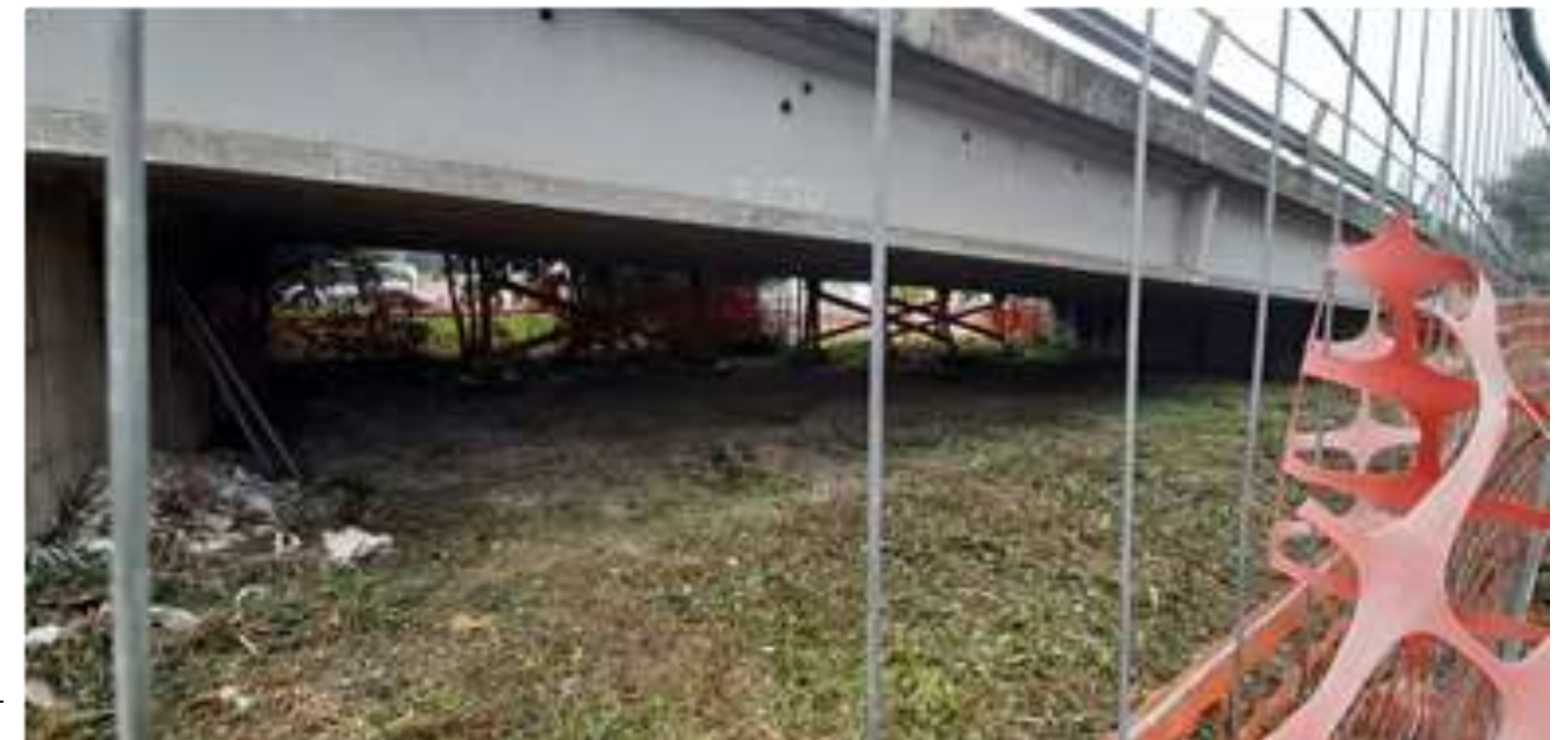
Vista impalcato SDF
