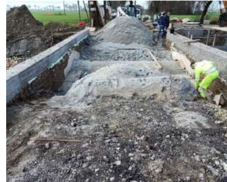
Consolidamento volta
