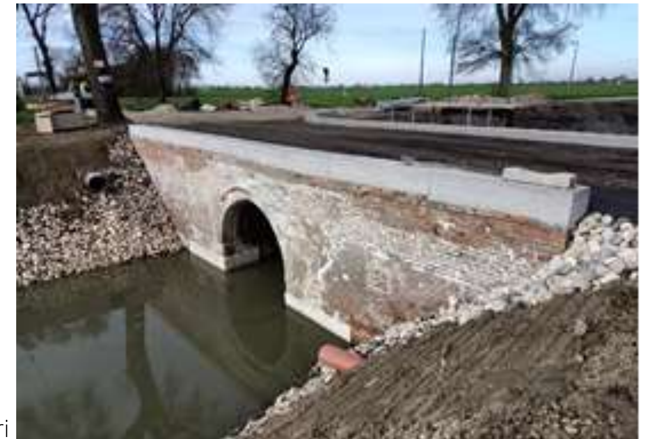
Consolidamento volta
