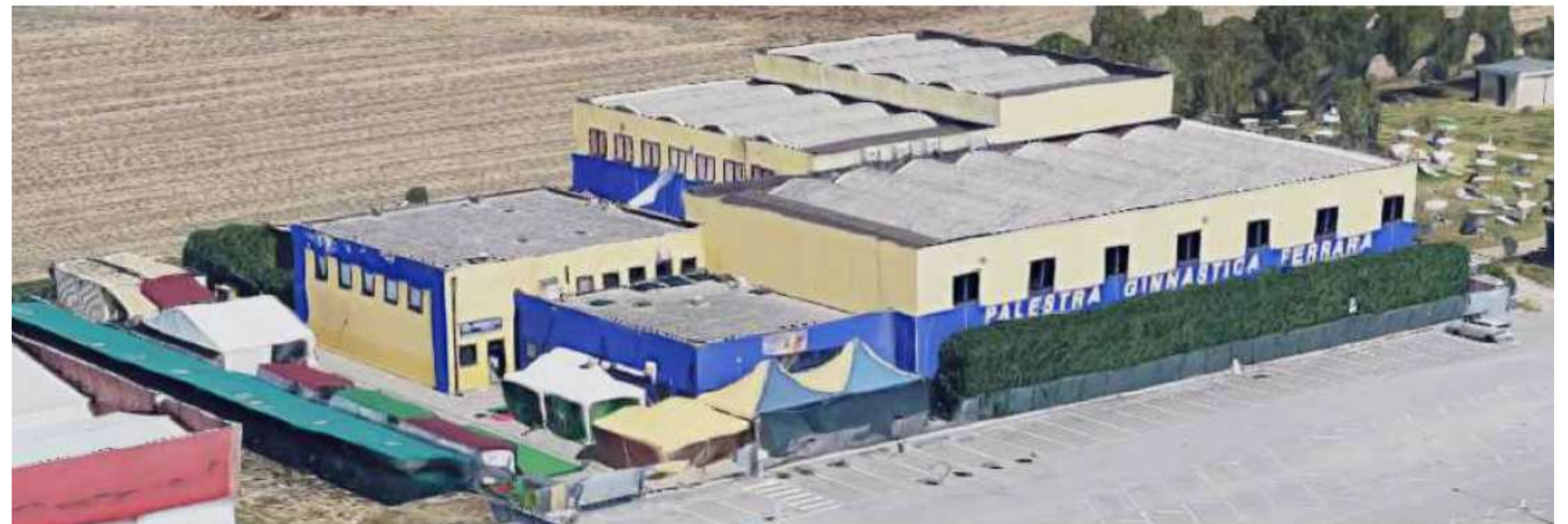
Vista del fabbricato
