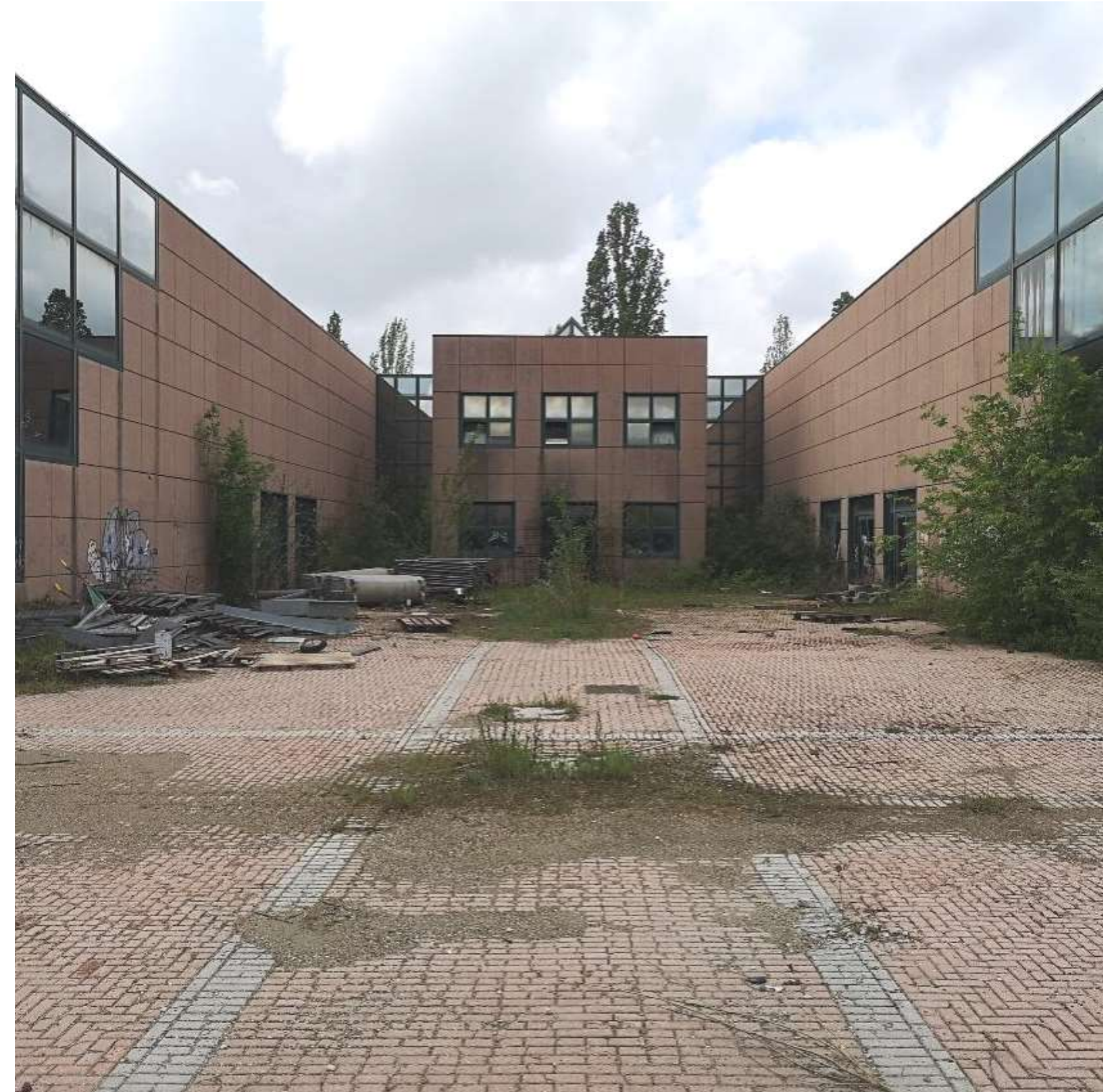
Vista del fabbricato blocco A
